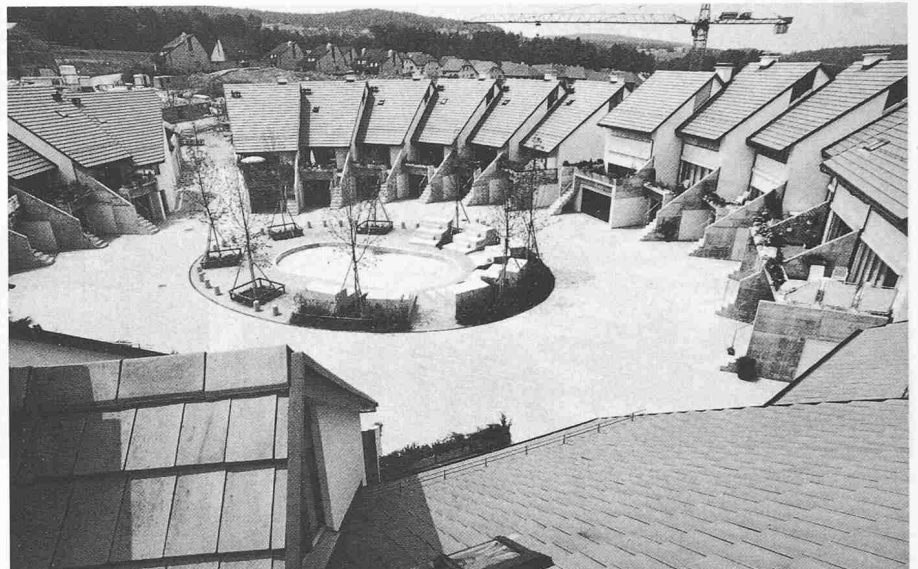
Überbauung Sonnenhof. Hofansicht mit Eingangspartie
