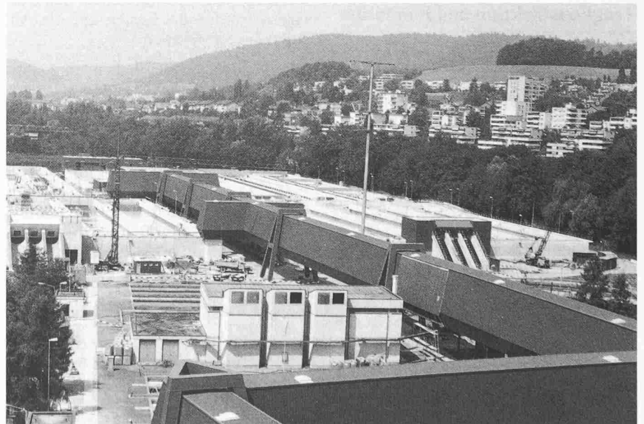
Bild 1. Blick auf den fertig verkleideten Hochkanal im westlichen Teil der Anlage
