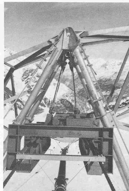
Bild 7. Mittelstütze, Seilsattel
