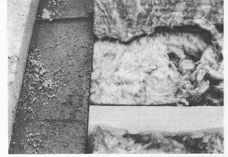
Element mit unterseitig aufkaschierter Dampfsperre über nicht bewohntem Estrich und guter Luftdichtung des darunterliegenden Bodens; Materialien in einwandfreiem Zustand, keine Pilzbildung und Feuchtigkeit feststellbar
