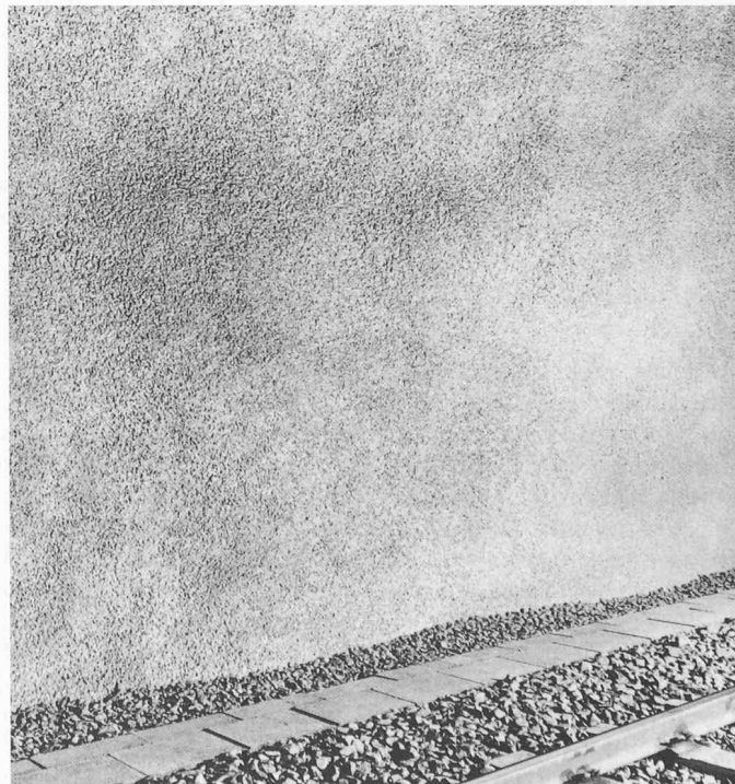
Bild 11. Sorgfältig hergestellte Spritzbetonfläche (Foto: O. Pfeifer, Luzern)
