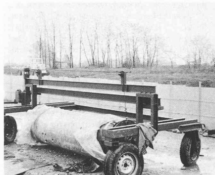
Bild 3. Für das Verlegen wurden die 2,50 m breiten und bis zu 185 m langen KDB in ein fahrbares Gerüst eingehängt, von dem sie von Hand abgerollt und quer durch das Becken bis zur gegenüberliegenden Böschungskrone gezogen wurden (Foto: Sarna Kunststoff)
