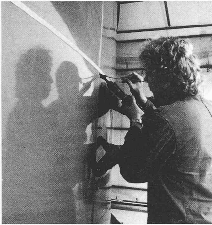
Auf den Wickelkern, der in Leichtbauweise aus Einzelsegmenten aufgebaut ist, werden zunächst etwa 4 mm dicke Platten aus PVC aufgebracht und an den Stössen verschweisst
