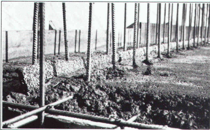
Erstellen einer Anschluss-Dichtung "BFL-MASTIX" Typ 20/70 R4.
