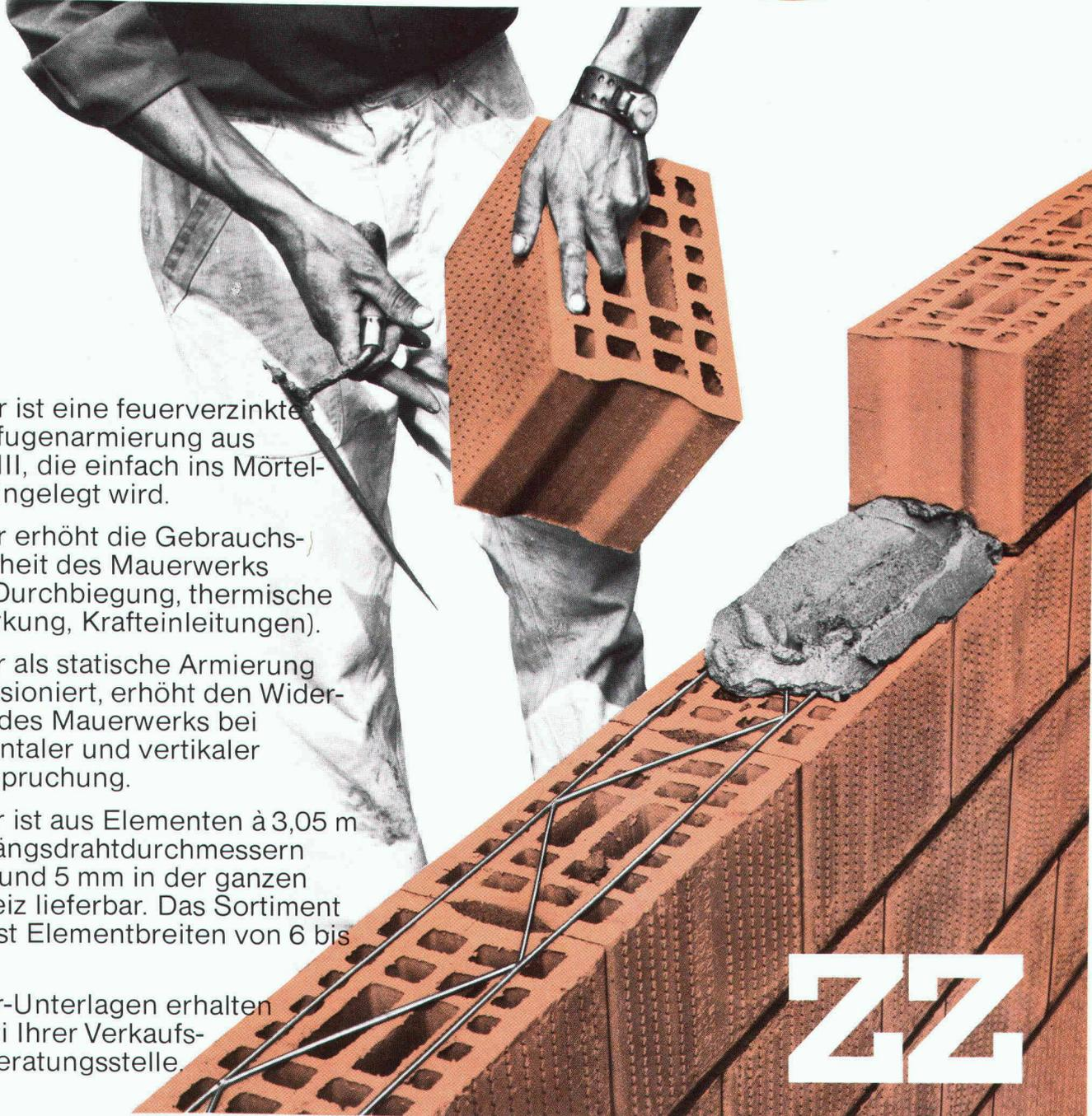
murfor ist eine feuerverzinkte Gittergitterarmierung aus Stahl III, die einfach ins Mörtelbett eingelegt wird.
