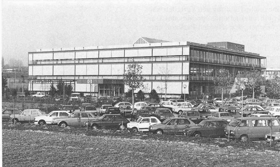
Bild 2. Südwestfassade mit geschlossenen Storen vor den Laufstegen
