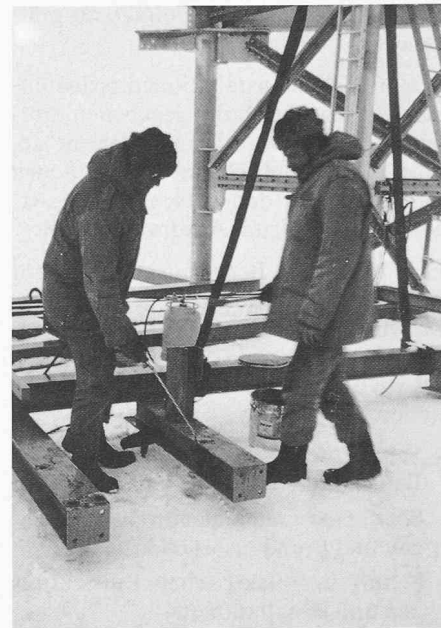
Bild 15. Stahlbaumonteur mit Windjacke und Pelzmütze (statt Bauhelm)
