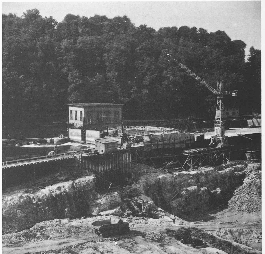
Bild 8. Aushub im Rheinbett für das Kraftwerk Schaffhausen, Blick nach Süden. Man beachte die Klüftung des Kalkfelsens und das Ausmass des Aushubs (Foto R. Fechtig 27.7.1961)
