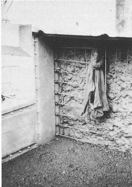
Bild 4. Freigelegte Ankerköpfe und bereits gekoppelte Armierung
