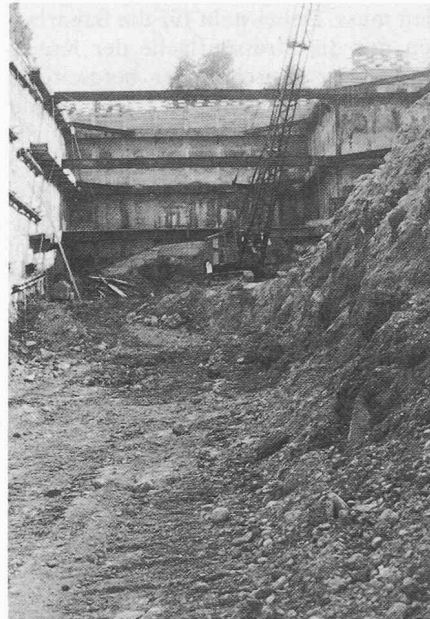
Bild 10. Portalbaugrube Seite Stettbach
