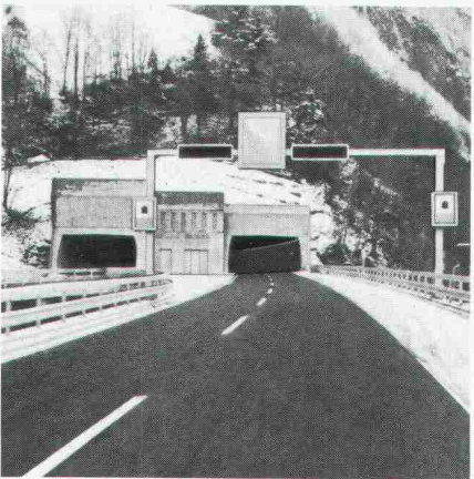
... wo Strassentunnels sicher sein müssen
