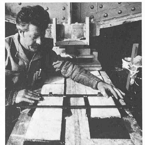
Bild 14. Einbau der teflonbeschichteten Neoprenkissen
