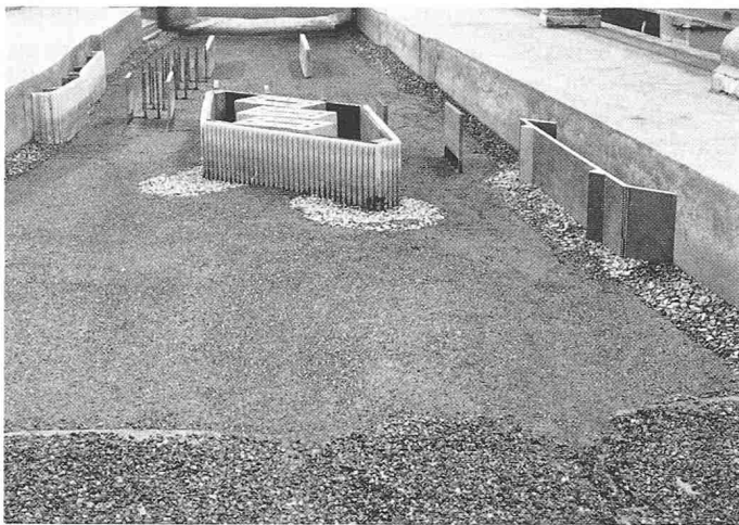
Bild 12. Eingebauter Kolkenschutz durch Steinschüttung in den am meisten gefährdeten Zonen (2. Bauetappe)
