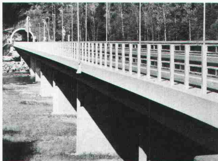
Autobahnbrücke Als frost- und tausalzbeständige Beschichtung
