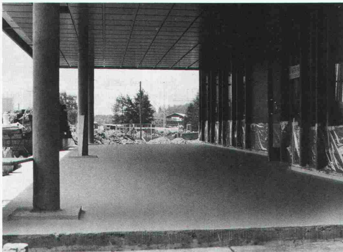
Eingangshalle Kläranlage Als wasserdichte Isolation unter Plattenbelag
