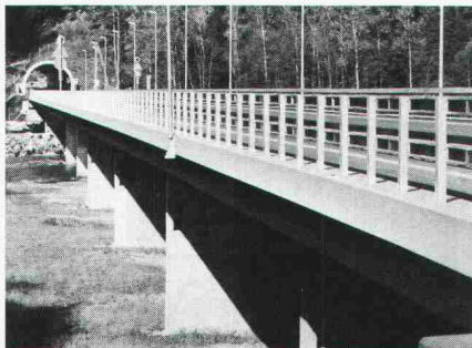
Autobahnbrücke Als frost- und tausalzbeständige Beschichtung
