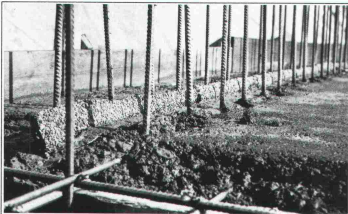
Erstellen einer Anschluss-Dichtung "BFL-MASTIX" Typ 20/70 R4.
