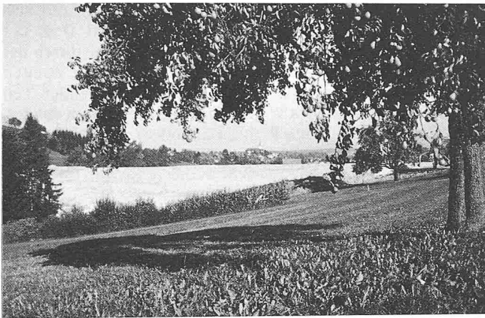
Bild 5. Der Staudamm Greuel bei Muri für den Hochwasserrückhalt am Rüeribach kurz nach der Vollendung im Herbst 1984. Ansicht von Oberwasser. Höhe 16 m, Länge 160 m, Schüttvolumen 50 000 m 3 (Foto Motor-Columbus).
