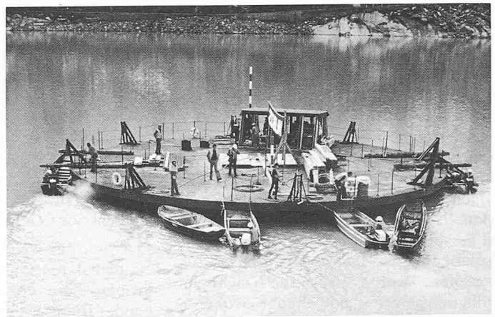
Bild 7. Das untere Einlaufbauwerk des Pumpspeicherwerkes Grimsel-Oberaar während des Einschimmens (1976). Das Betonbauwerk gleicht einem Hohlzylinder mit 21,70 m Durchmesser und 7,25 m Höhe. Sein Gewicht beträgt 1200 t, sein Auftrieb wird durch rund 1000 m 3 Polystyrol-Hartschaumstoff gewährleistet (Foto IUB).
