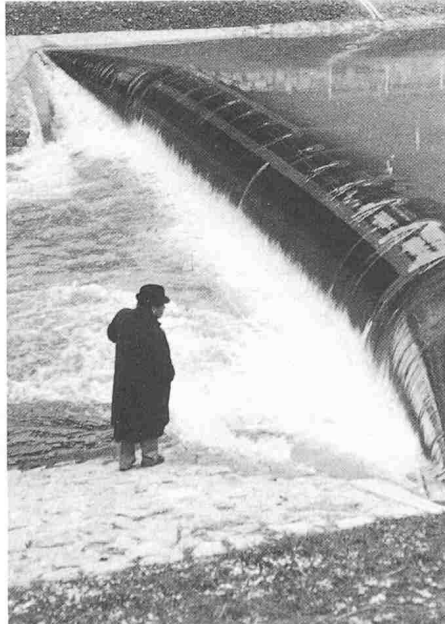
Bild 2. Das Schlauchwehr Hochfelden in der Glatt als Notverschluss für ein Ölwehr-Dispositiv. Stauhöhe 1,6 m, Schlauchlänge 22 m, Material 5 mm starker Neopren Gummi mit Nylongewebe (Foto VAW).
