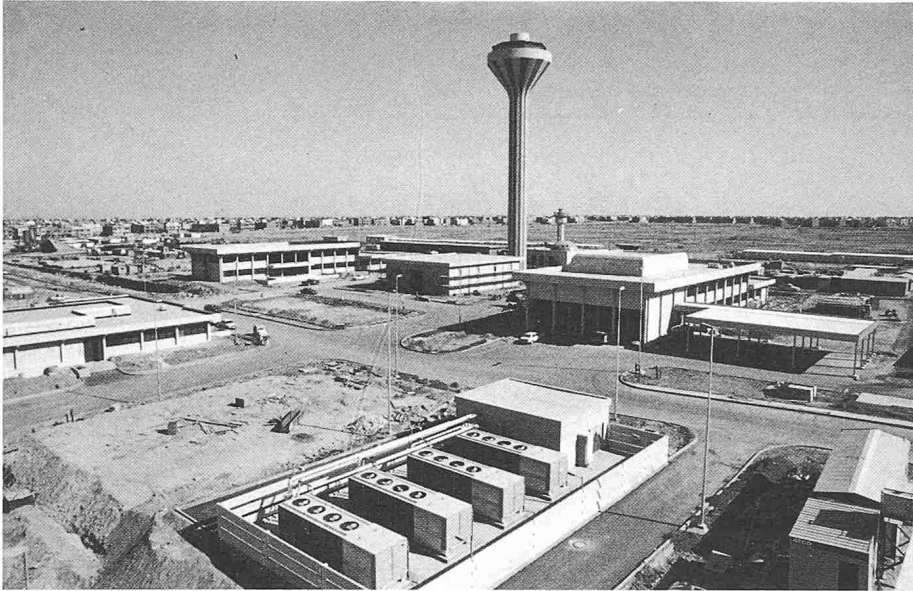
Bild 14. Zentraler Bereich mit Administration und Wasserturm
