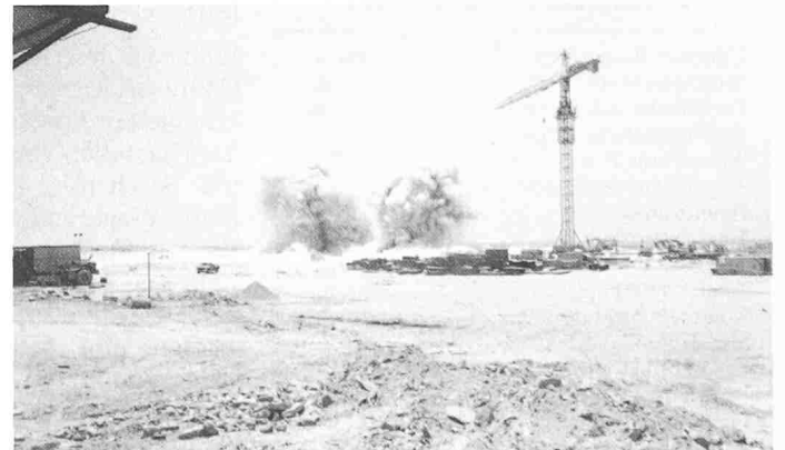
Bild 13. Sprengarbeiten. Pre-splitting
