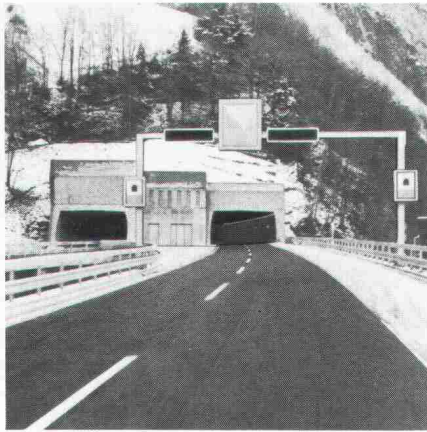
... wo Strassentunnels sicher sein müssen
