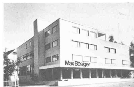
9114 Langenthal 1914-16 Haus Mittestrasse 13-15, Arch. Bösiger Walter
