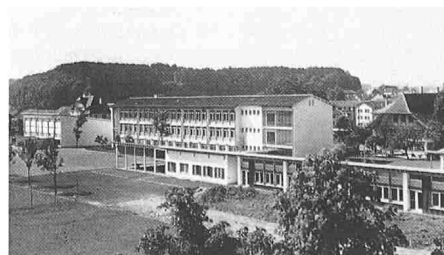
3104 Bern 6, Bümpliz 1949-50 Primarschule Statthaltergut, Wangenstrasse 9, Arch. Brechbühler Hans, Wettbewerf
