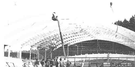
9119 Langenthal 1982-84 Überdachung Kunsteisbahn, Ing. Duppen-thaler + Wälchli
