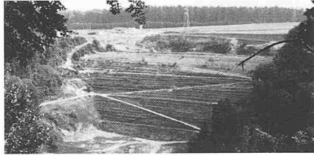
2526 Mühleberg 1977-79 N1 Erddamm Salzweid, Ing. Hürzeler Fritz (Autobahnamt)
