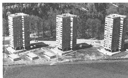
3140 Bern 3, Fischermätteli 1960-62 3 Hochhäuser, Holligenstrasse, Arch. Althaus Willy
