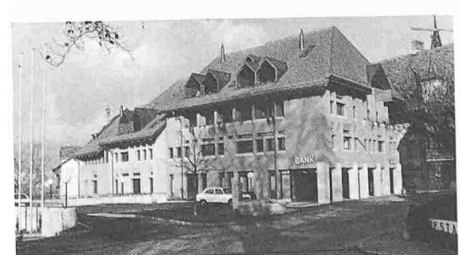
4320 Büren a.d. Aare 1981 Spar- und Leihkasse und Wohnungen, Arch. Strasser Ulyss
