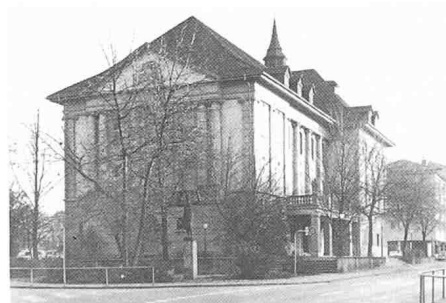
9112 Langenthal 1914-16 Neubarockes Stadttheater, Aarwangenstrasse 8; Arch. Keiser und Bracher
