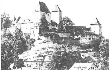
8126 Burgdorf 1974-83 Schlossfelsanierung nach denkmalpflegerischen Anforderungen Assainissement de roches au château selon les critères de la protection des monuments et sites, Ing. Steiner + Buschor AG, Publ. Bericht Kt. Baudirektion 5/1984
