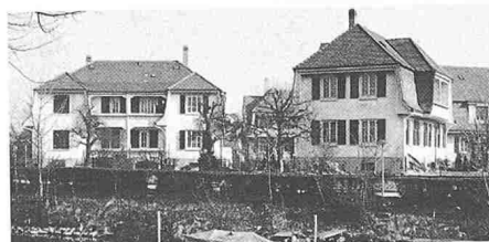
4230 Nidau 1911 Eisenbahner-Genossenschaftssiedlung Hofmatte, Arch.gem. Moser E. und Schürch W.
