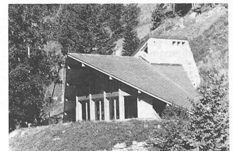
0011 Susten 1962 Einfamilienhaus, Arch. Anderegg E.
