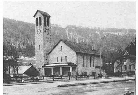
5210 Villeret 1961 Chapelle catholique, Arch. Bueche Jeanne
