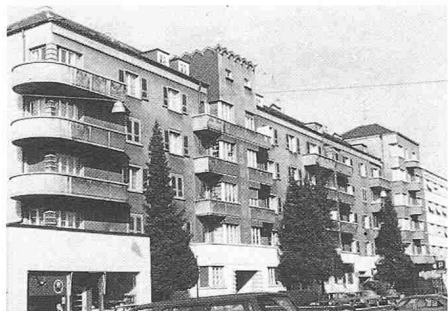
6028 Biel 1930-37 Brühlhof, Mattenstrasse 83-93, Arch. Wildbolz + Rickli
