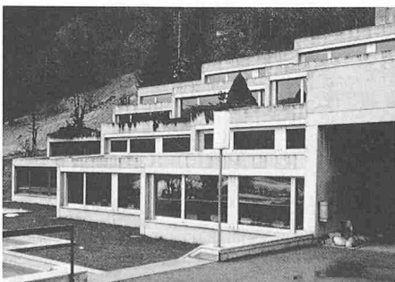
5203 St-Imier 1960-62 Collège secondaire, Arch. Brugger Frédéric
