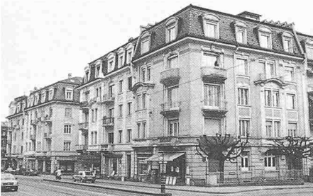
3052 Bern 3, Weissenbühl 1904-06 Baugeviert Seftigenstrasse/Dappelsweg/Holzgkofenweg/Weissenbühlweg, Arch. Römer und Fehlbaum
