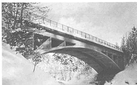
0190 Adelboden 1930 Spitalbrücke, 3 km unterhalb Adelboden (Kantonsstrasse), Ing. Maillart Robert, Publ. Bauzeitung April 1938
