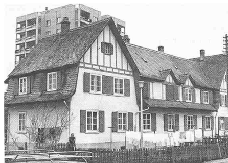
9111 Langenthal 1907-14/1918-31 Gemeinnütziger Wohnungsbau, Oberfeld, Kirchfeld, Haldenquartier (Foto), Arch. Egger Hektor
