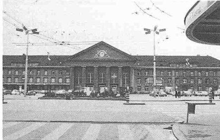
6011 Biel 1919-25 Bahnhof in Geleisehochlage , Arch.gem. Moser E., Schürch W., v. Gunten A. und Eidg. Bauten (Wettbewerb)
