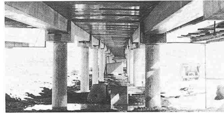
2411 Münchenbuchsee 1978–79 U10 Autobahnüberführung (bei Moospinte), Ing. Leisi & Messerli/Geotest AG
