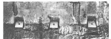
3204 Bern 2, Enge 1984 Bedag: 22 m tiefe Baugrube in Molasse, Engehaldenstrasse, Ing. Weber + Brönnimann AG
