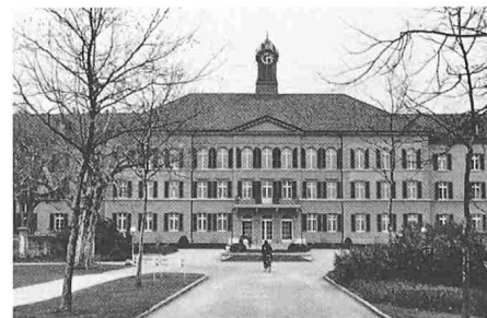
3003 Bern 5, Waldau 1851-55 Hauptbau Psych. Universitätsklinik Waldau, Arch. Hebler Gottlieb
