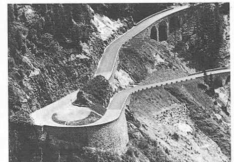
0010 Susten 1938-46 1. Ausbau der ehemals 8 «Bergfuss» breiten Sustenstrasse auf 6 m, Ing. Vögeli T. und Nil F., Baudirektor Bösiger
