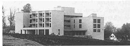
2410 Münchenbuchsee 1978–79 Altersheim, Arch. Hebeisen und Vatter
