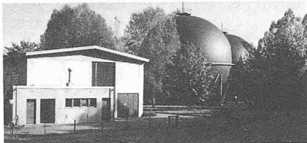
3300 Bern 3, Marzili 1843/1876/1967 Gasversorgung Bern
