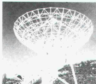
Antenne der Satellitenbodenstation in Leuk VS
