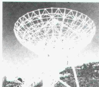
Antenne der Satellitenbodenstation in Leuk VS
