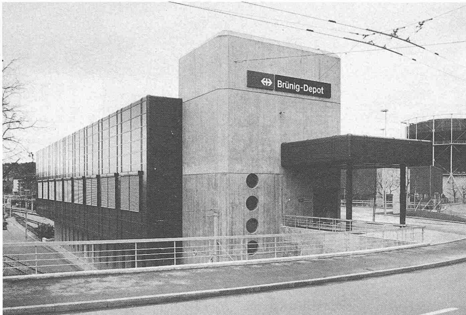
Bild 1. Das neue Brünigdepot am Süden der Gleisanlagen
