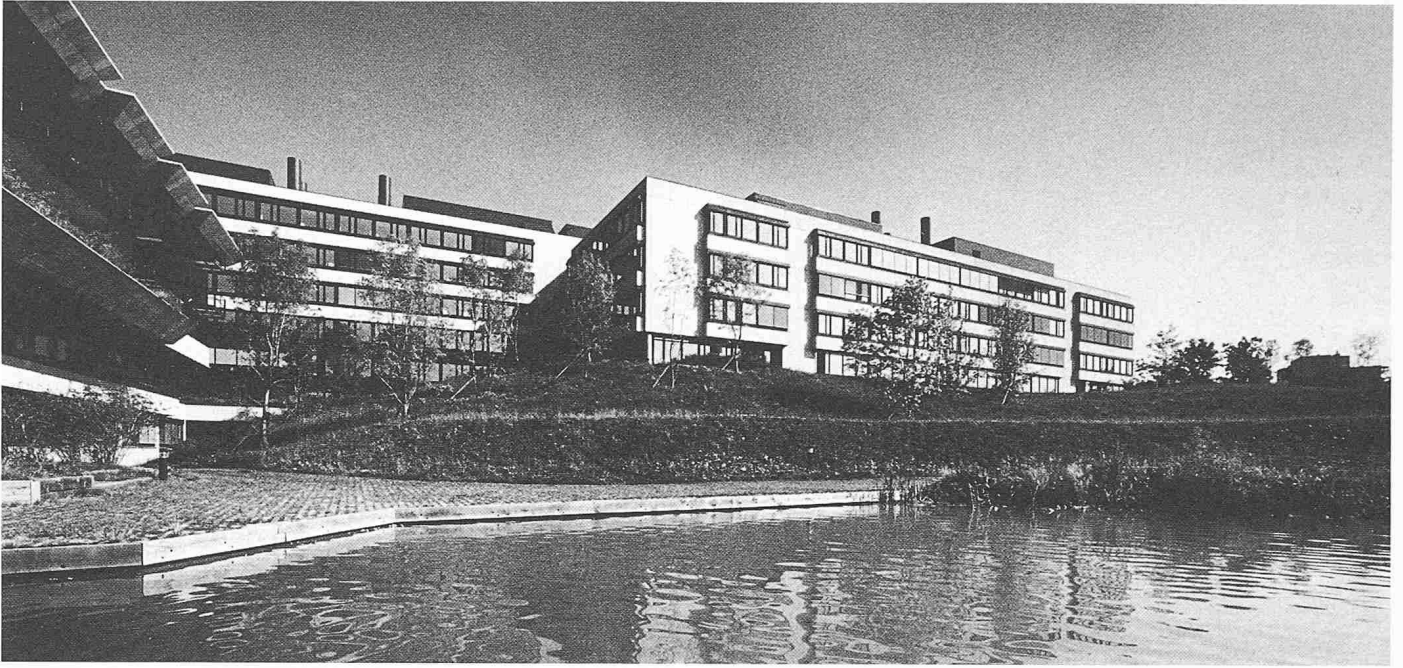
Institutsbauten der 2. Etappe. 2 vertikale Schachtzonen unterbrechen die Laborräume. An den Schmalseiten sind die Büros untergebracht. Links der Mensabau, im Vordergrund der künstliche Teich zwischen Universität und Staatsarchiv
