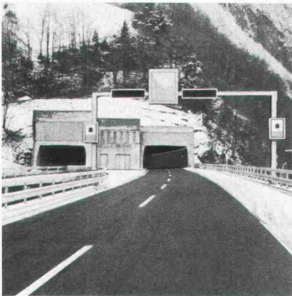
... wo Strassentunnels sicher sein müssen
