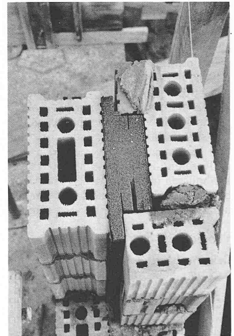
Bild 5. Kerndämmung aus Foamglas-Boards an einem gemauerten Pfeiler
