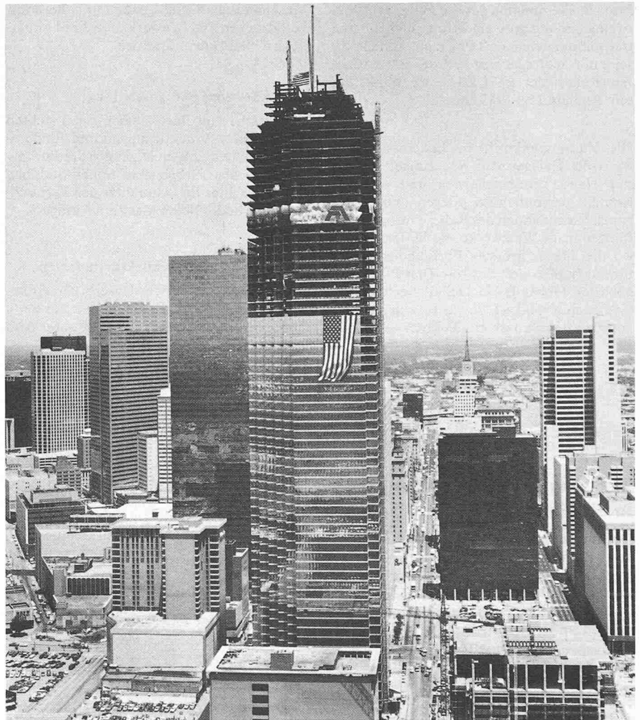
Bild 3. Interfirst Plaza in Dallas (Texas) mit Trägern aus Diffendingen
