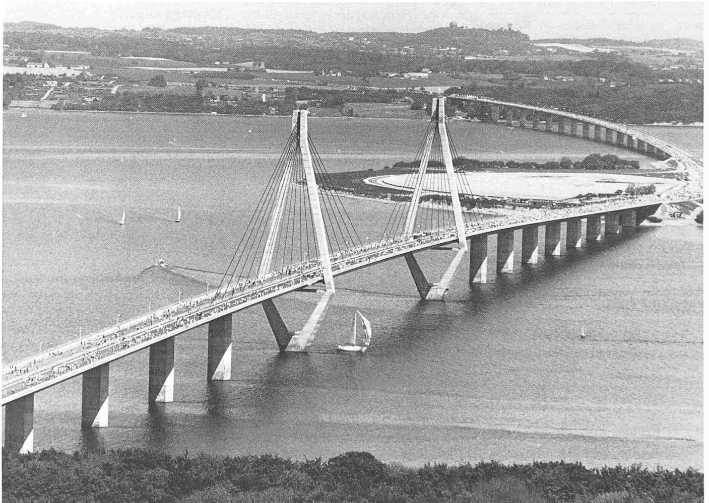
Bild 3. Die Schrägkabelbrücke Farø-Falster
