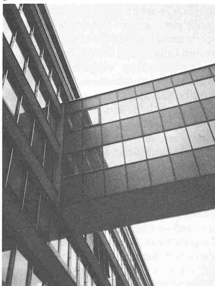
Bild 3. Sorgfältig gestalteter Übergang zum Bürogebäude
