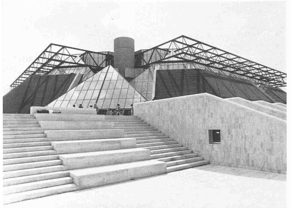
Bild 4. Eingangspartie der Halle
