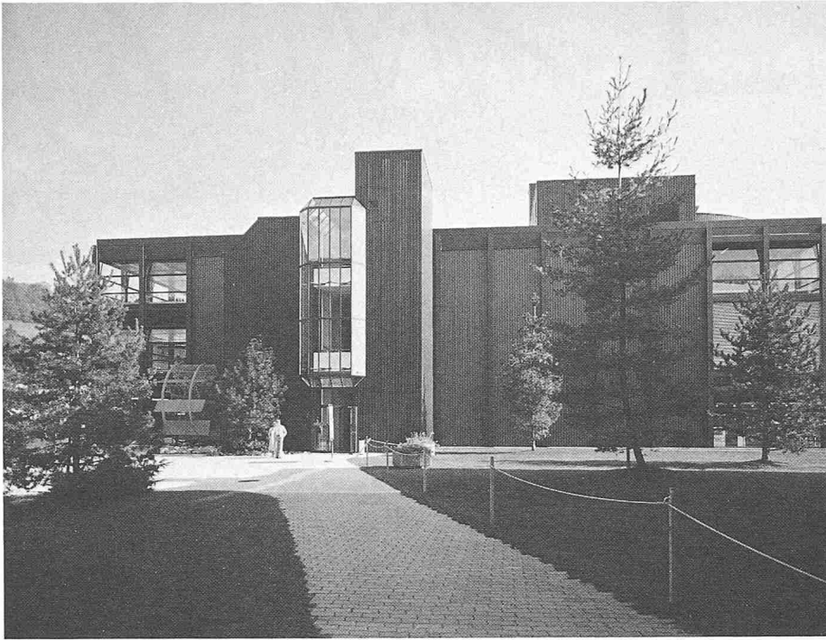
Bild 1. Halle Schiffahrt, Seilbahnen, Tourismus des Verkehrshauses der Schweiz, Luzern
