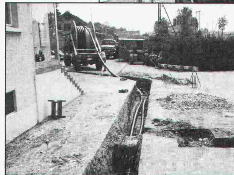
FLEXWELL- Leitungen von der Rolle in den Gräben
