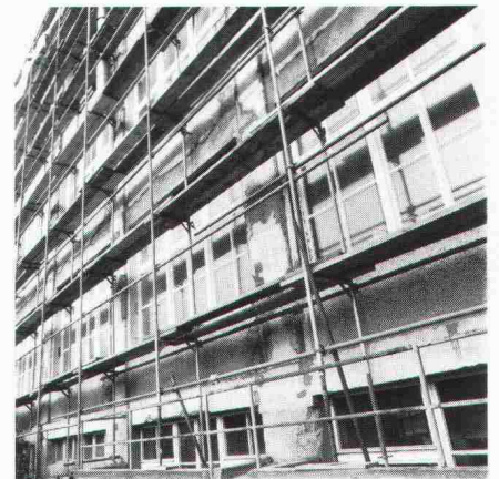
... wo Beton durch Umwelteinflüsse gefährdet ist
