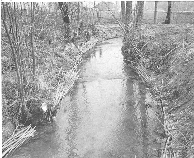
Bild 7. Rotbach: Unterspülte Gehölzufer werden mit Uferfaschinen unterfangen
