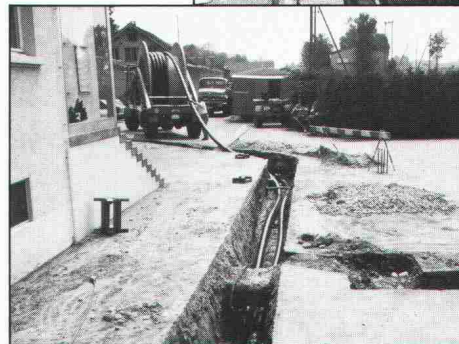
FLEXWELL- Leitungen von der Rolle in den Graben
