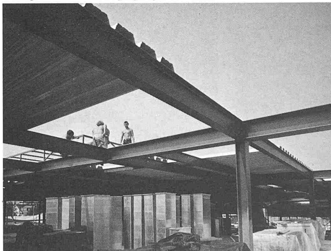
Bild 8. Im Baukastensystem verschraubte Dachträger eines Einkaufszentrums. Montage und Ausbau verlaufen fast parallel
