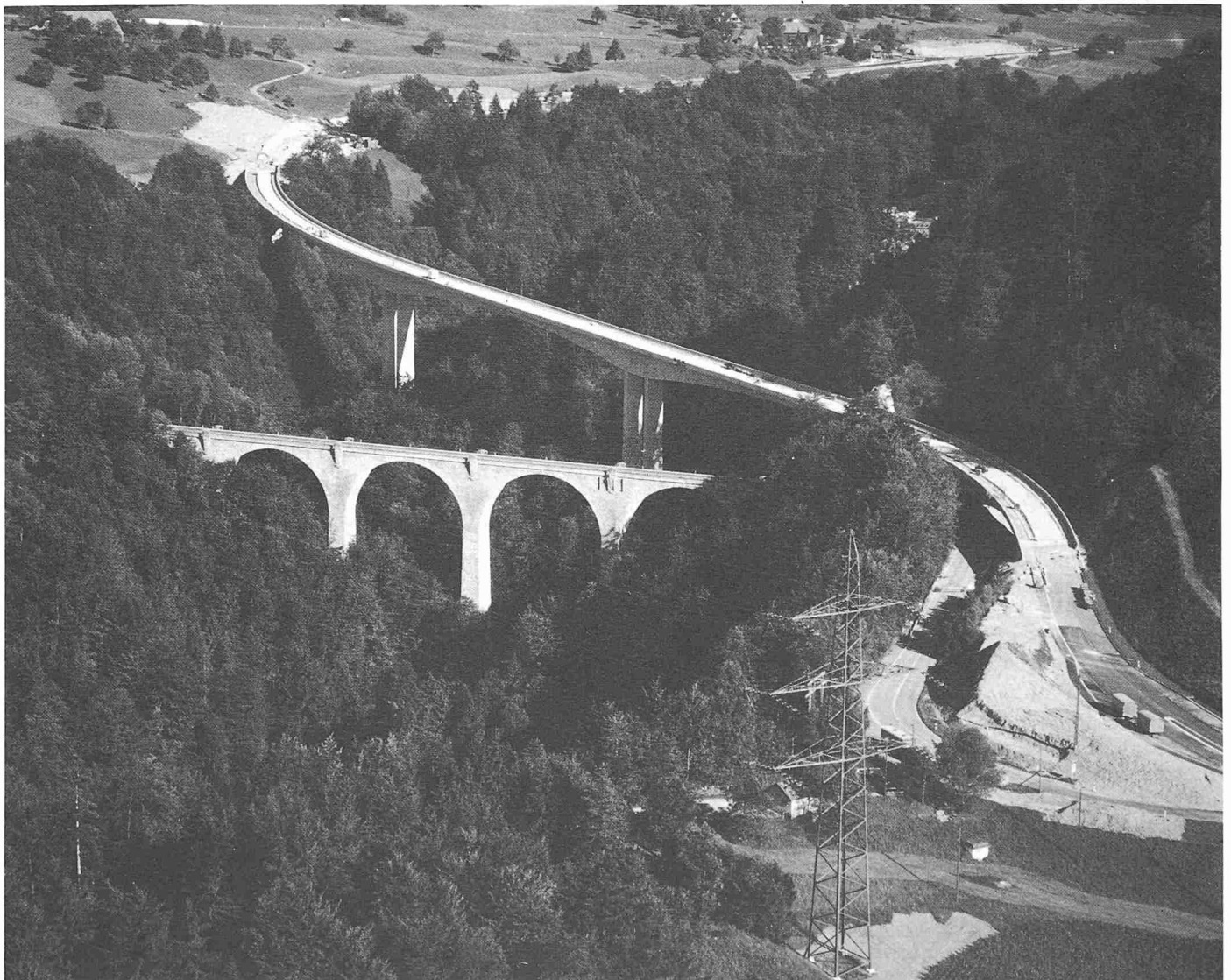
Alte und neue Lorzentobelbrücke
