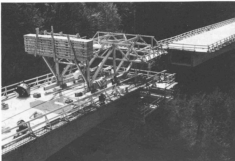
Gegengewichte bildeten beim Freivorbauwagen die Schalungsfixation beim Vorfahren des Wagens
