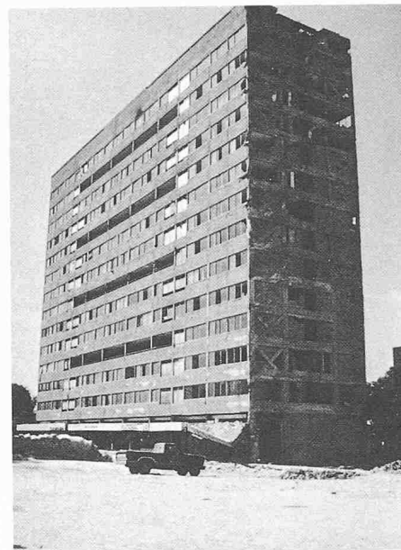
Bild 13. Stahlbetonskelett-Gebäude mit Aussteifungen mittels Stahlbetondiagonalen (ein analoges, direkt anschliessendes Gebäude stürzte ein, vgl. Bild 1a, Tlatelolco-Bezirk)
