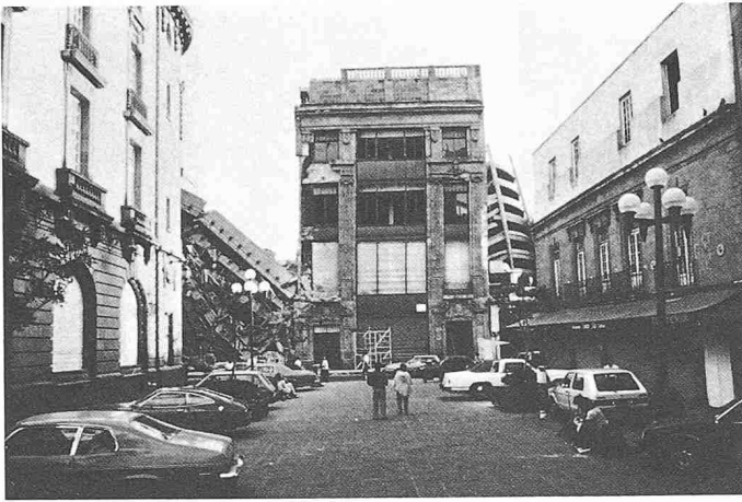
Bild 15. Die zwei Parkhäuser hatten eine tiefe Eigenfrequenz und wurden durch die Schwingungen zum Einsturz gebracht, während die beiden älteren Gebäude links und rechts im Bild dank ihrer steifen Wände ohne sichtbare Schäden blieben
