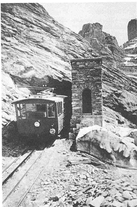
Jungfrau-Bahn JB Eingang zum Tunnel während der Bauperiode
