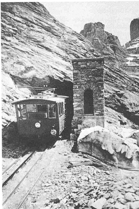
Jungfrauabahn JB Eingang zum Tunnel während der Bauperiode
