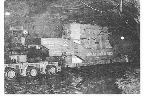
Handeck III Transport eines 62-MVA-Trafos, Ingenieur-Unternehmung AG, Bern
