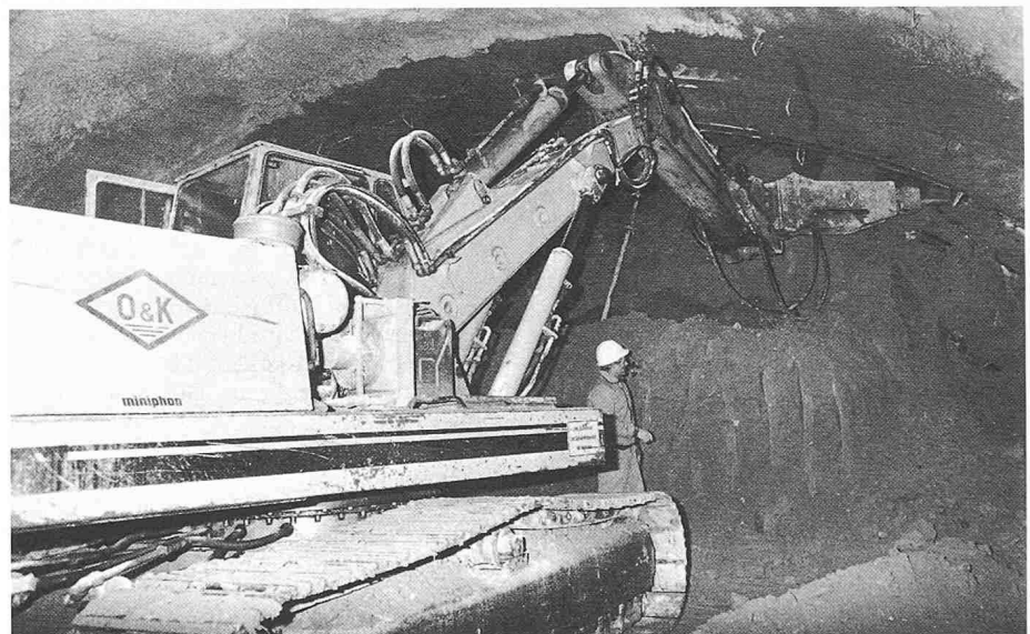
Bild 3. Tunnel Rämistrasse. Ausbruch unter dem Gefrierkörper
