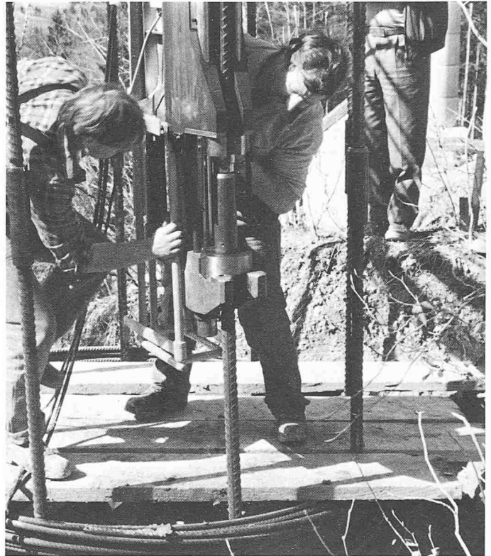
Bild 3. Verpressen des Muffenstosses. Die Presse wird von der Seite her aufgesetzt
