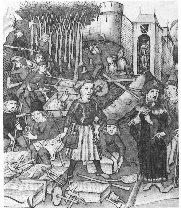
Mittelalterliche Baustelle. Zu erkennen sind folgende Arbeitsvorgänge: Steinmetzarbeiten und die dazugehörigen Werkzeuge, Mischen und Abtransport des Mörtels sowie das Schlagen von Bauholz. Beide Abbildungen stammen aus der Spiezer Chronik des Diebold Schilling
