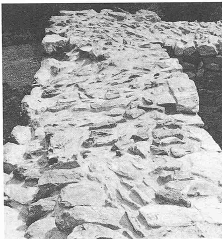
Zwing-Uri UR. Mauerkrone des Turmes nach der Konservierung
