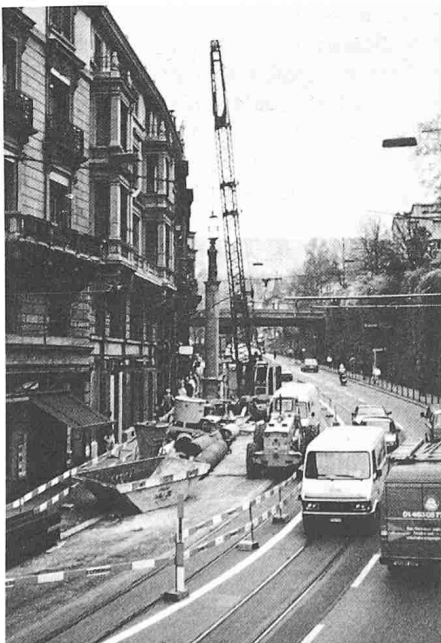
Bild 11. Erstellung der Bohrungen für Rühlwandträger
