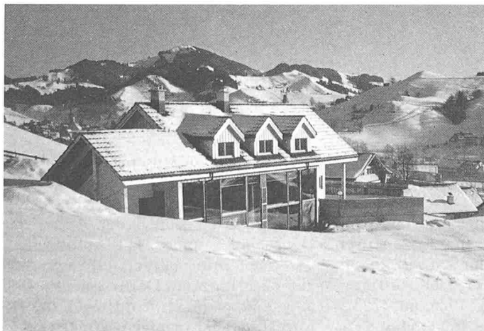
Bilder 1 und 2. Einfamilienhaus Dr. E. Taverna (Objekt 6). Sonnenwärmesystem mit schwarzer Lamellenstore im Luftraum zwischen zwei Zweifachverglasungen bzw. Lamellen-Luftkollektor hinter Zweifachverglasung, solarzellengetriebener Ventilator und Geröll-Wärmespeicher unter der Wohnzone, Schwerkraft-Zentralheizung vom gemauerten Holzofen aus, Warmwasserbereitung mit Wärmepumpen-Boiler. Keine besonderen Anforderungen an die Bauhandwerker
