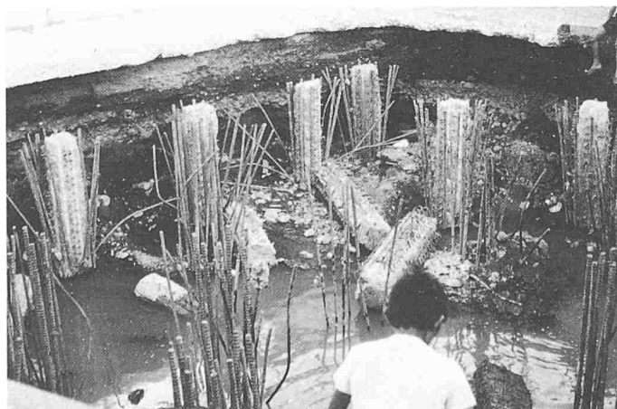
Bild 5. Nach dem Freilegen der Armierungseisen wird der obere Bereich der Pfähle in das Fundament integriert
