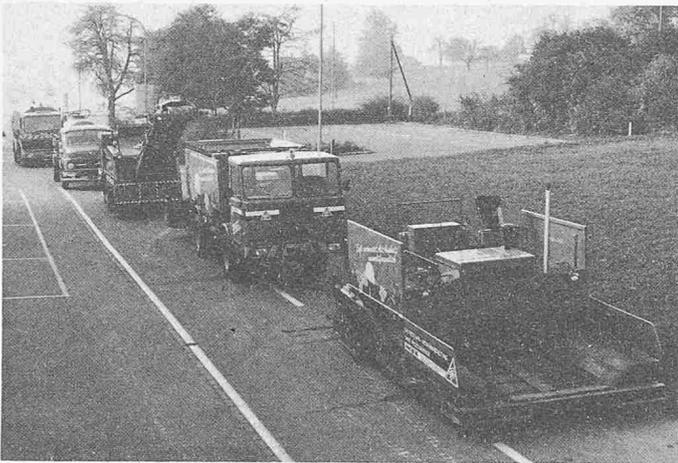
Strassensanierungs-Maschinen: Kaltrecycler, Kaltmikromaschine, Hochleistungs-Kaltfräse, Hochdruck-Waschmaschine, Saug-Wisch-Maschine.
