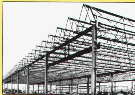
Metallstruktur eines Fabrikgebäudes mit Mini-Sheddach
