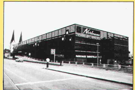
Mehrgeschossiges Parkhaus mit Zufahrt über Rampen
